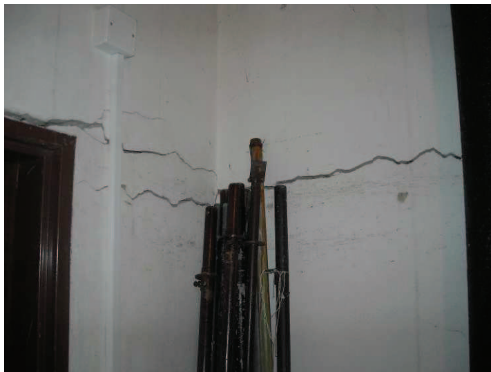
Obr. 12 Trhliny po poklesu terénu ve skladu v I. NP
