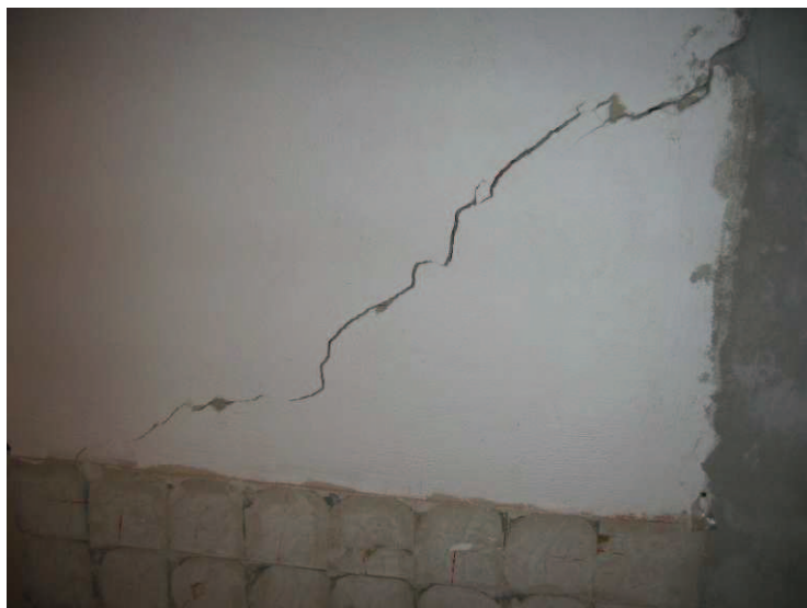
Obr. 10 Trhlina ve stěně v chladírně vedle kavárny, I. NP
