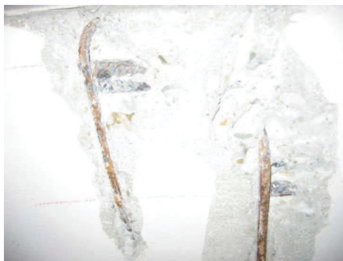
Obr. 3 Výztuž želez průvlaku v suterénu
