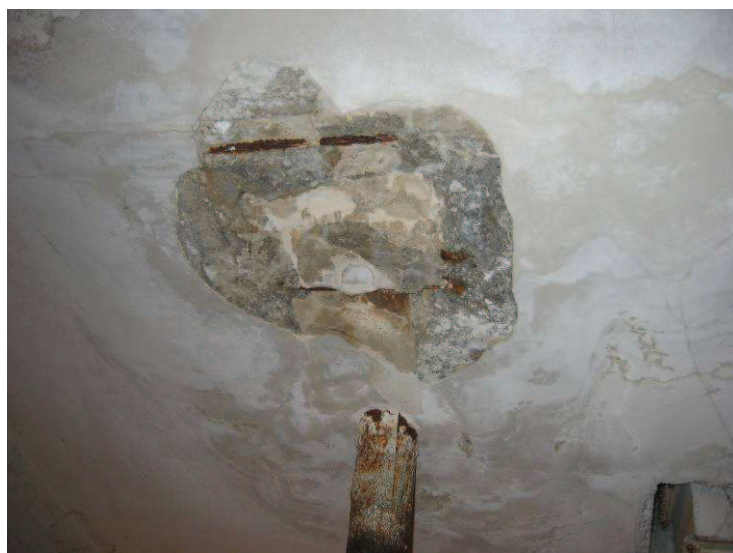
Obr. 5 Poškozená dobetonovaná část stropu, suterén, strojovna chlazení
