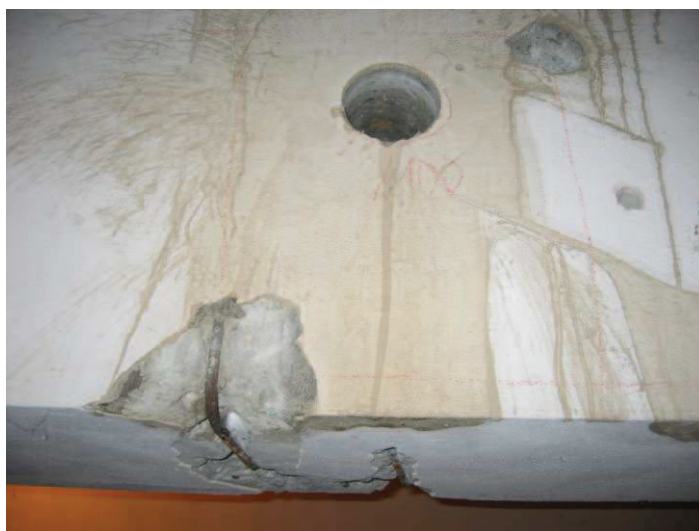
Obr. 2 Sondy na želez. průvlaku v suterénu
