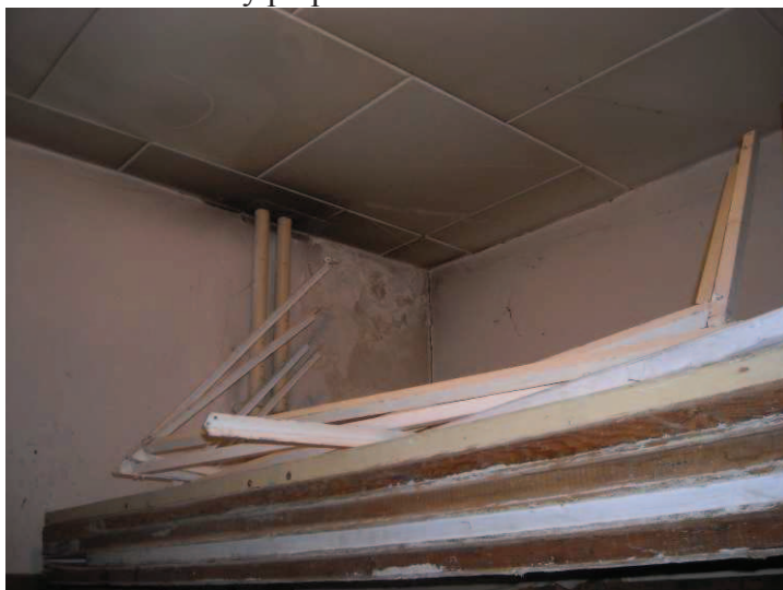
Obr. 13 Vlhkost pod stropem ve skladu v I. NP
