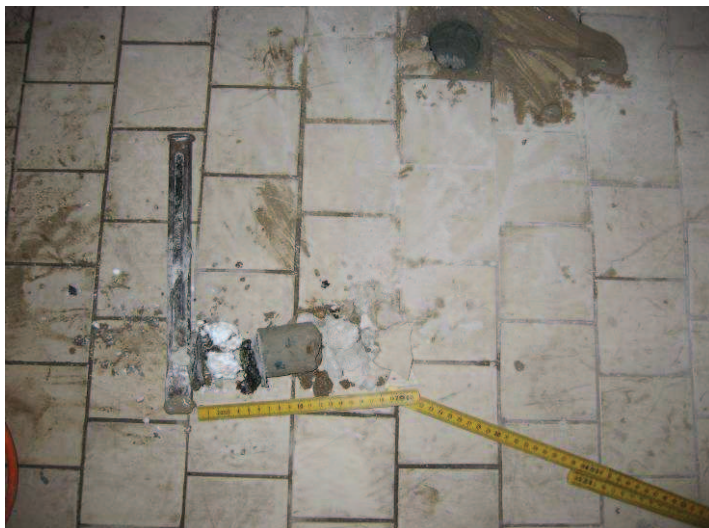
Obr. 9 Sonda do podlahy ve skladu kuchyně, I. NP
