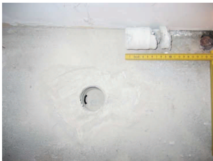
Obr. 14 Sonda do podlahy ve strojovně vzduchotechniky, II. NP
